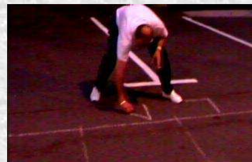
Traçage préventif au sol, sur parking fermé
